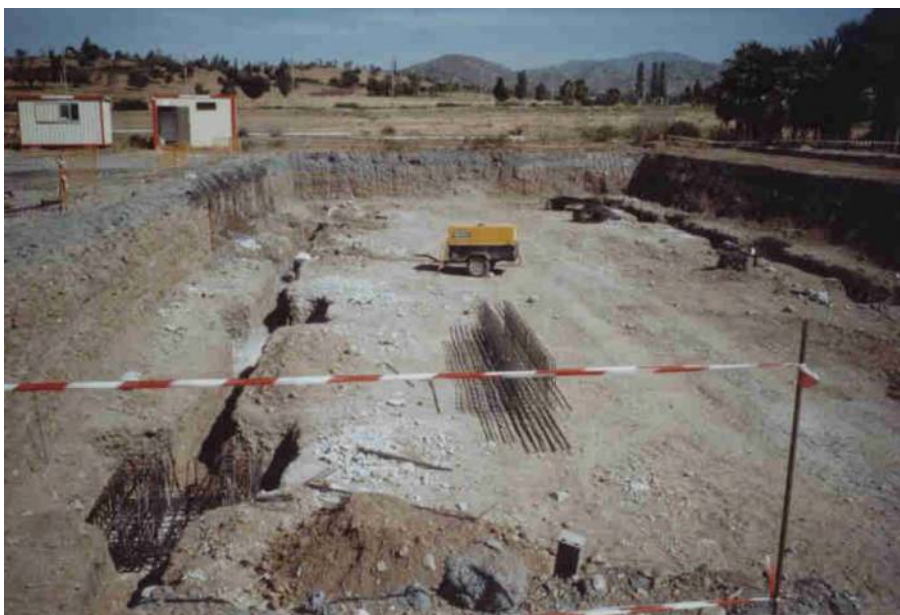
21 Vista general de la excavación
