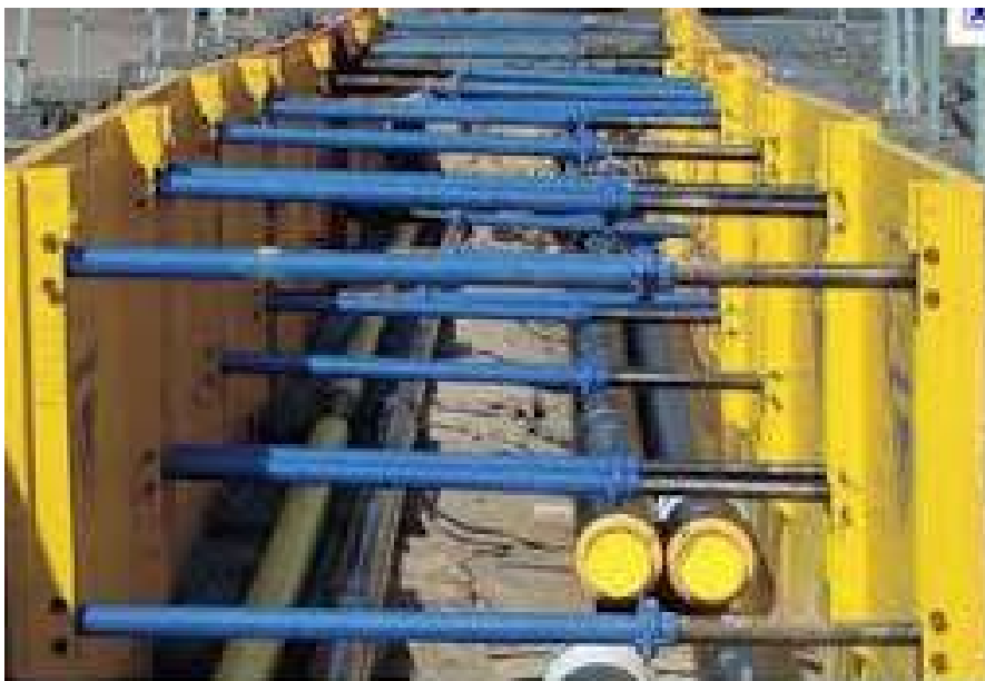
30 Entibación simple en zapata
